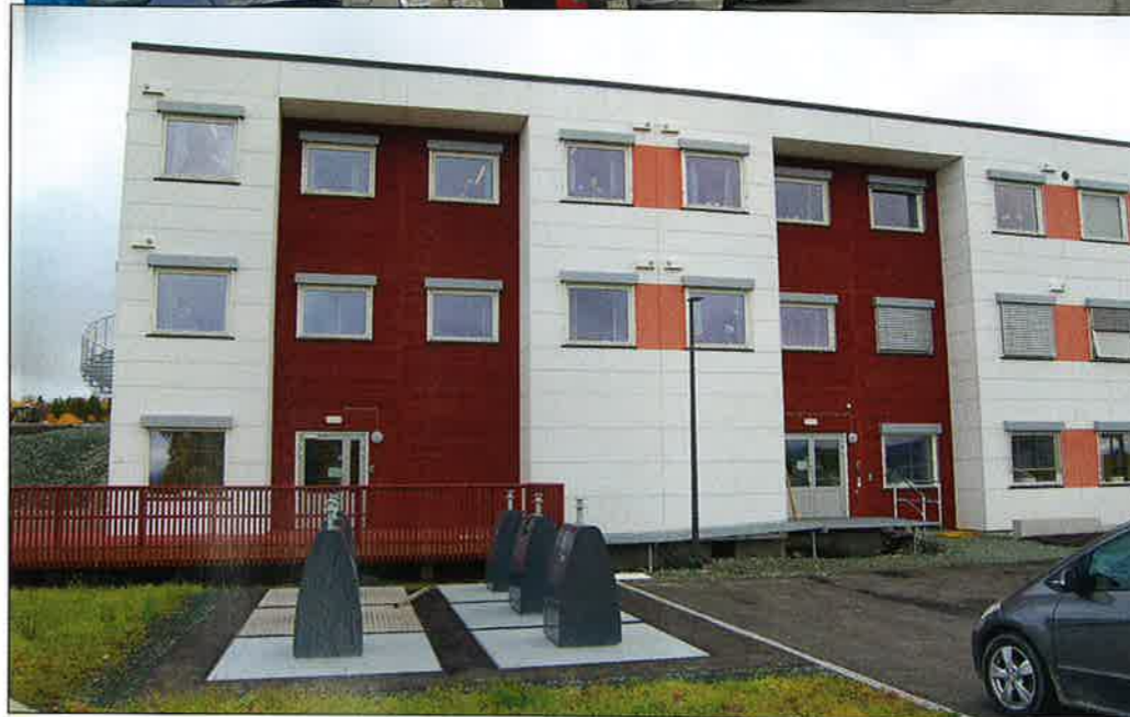
Fasaden på Dragvoll helse- og velferdssenter er kledd med fasadeplater og royal impregner tre.
